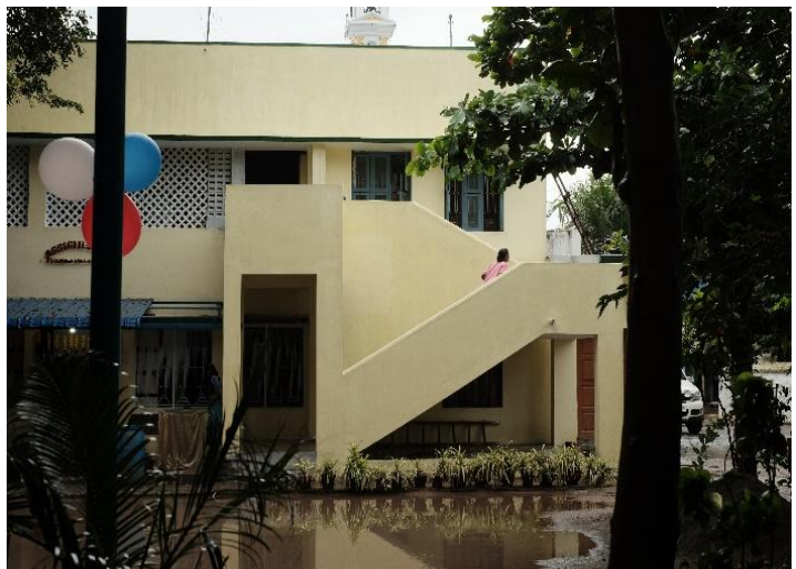
Voorgevel met nieuwe trap
