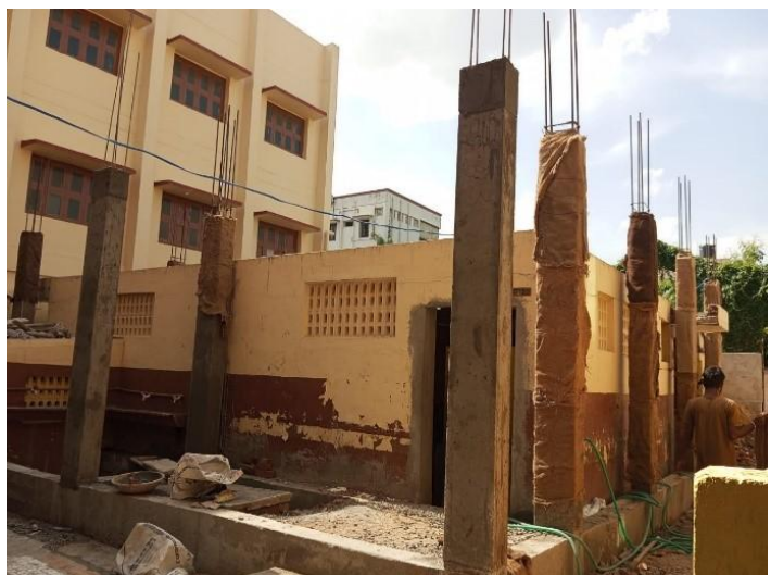
Nieuwe kolommen eerste verdieping rondom bestaande toiletgebouw
